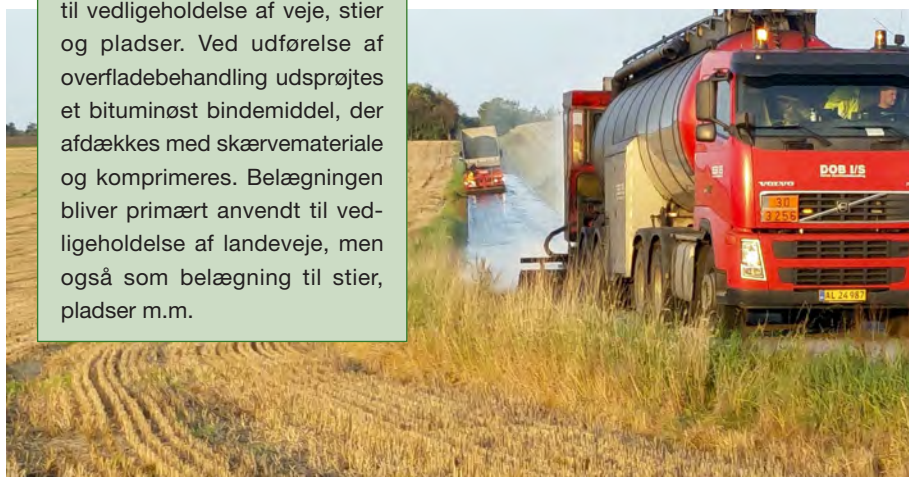
Figur 1. OB under udlægning.
