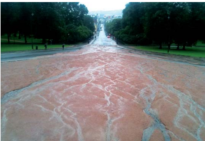
Før var der store problemer med gruset i regn. Foto: www.statsbygg.no.
